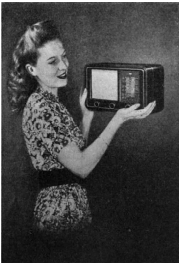
Die Zwergsuper interessieren im neuen deutschen Exportprogramm ganz besonders: klein, leicht und preiswert, sind sie exportgeeignet wie kein anderes Gerät, außerdem bilden sie den begehrten „Zweit-Empfänger“, den man leicht von einem Zimmer ins andere tragen kann (AEG 421).
